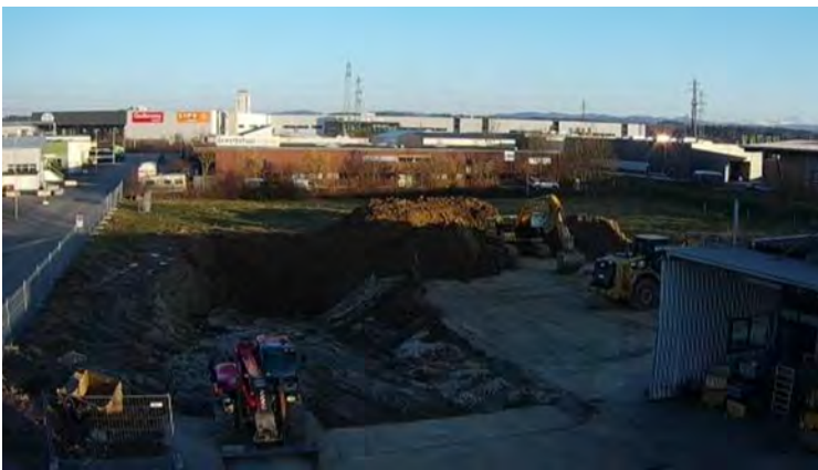
Die Bagger sind aufgefahren Webcam-Aufnahme vom Sonntag 13. Februar 2022 um 17.00
