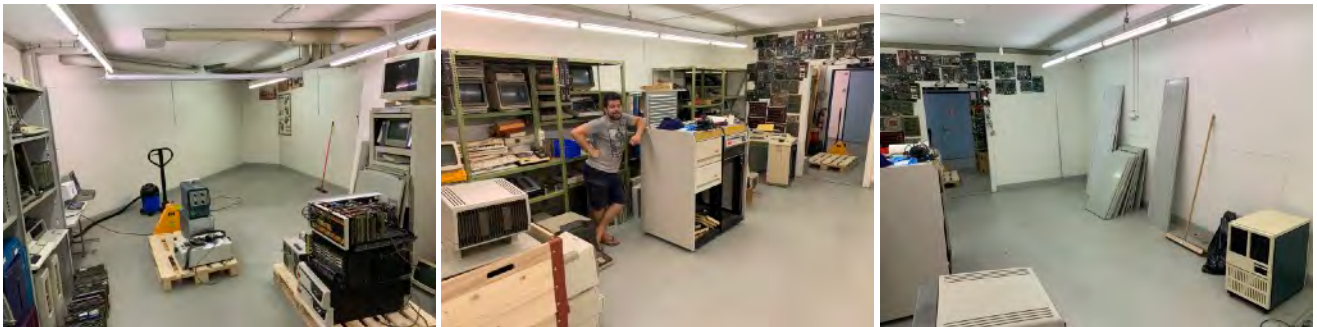
Räumung und Umbau des alten Schaulagers
